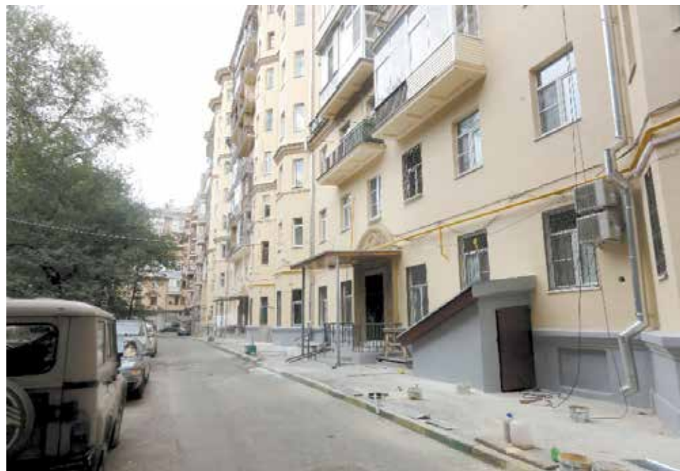
↑ На Космодамианской набережной, дом №42, ведутся фасадные работы.
