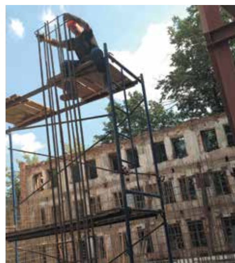
↑ На Космодамианской набережной, дом №38, стр. 1, ведутся фасадные работы.
